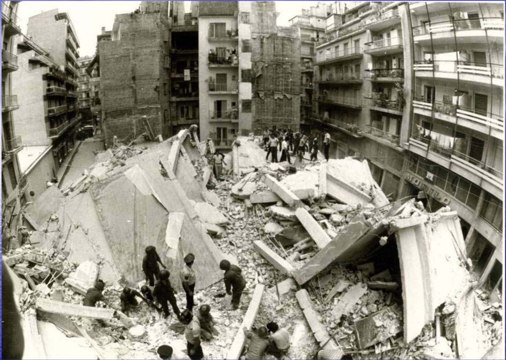
Εικ.2. Εικόνα από την κατάρρευση της θορόφου οικοδομής στην πλατεία ιπποδρομίου.
